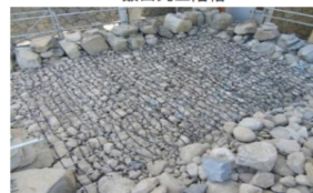
石垣補強材の施工状況
