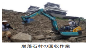
崩落石材の回収作業
