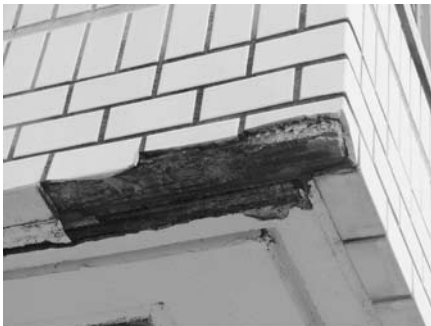
写真—1— バランダ下の鉄筋が錆びてコンクリートが爆裂
