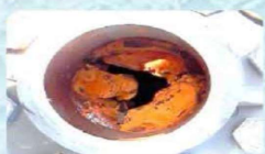
築33年経過した給水管の内部
