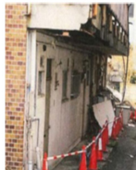
外壁剥落等の危険な状態
